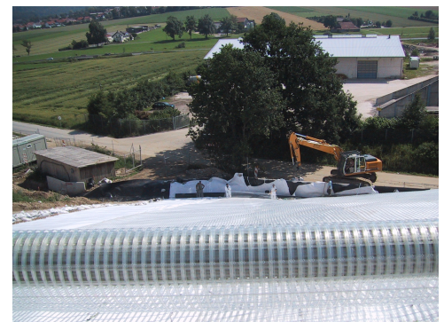
Einbau von Secugrid®
