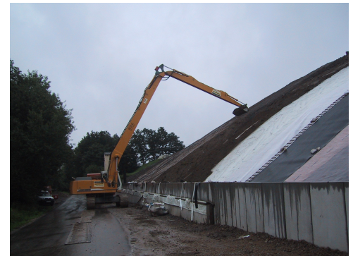
Einbringen des Oberbodens
