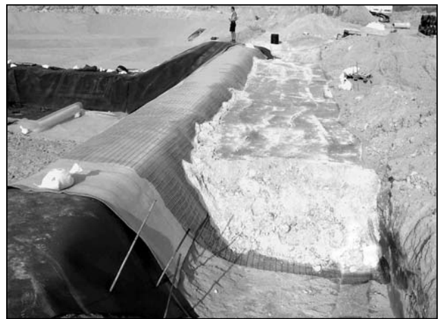
Abbildung 7 Anforderungsgerechter Einbindegraben
