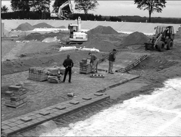
Abbildung 12 Einbau der Tragschichten und Pflasterarbeiten an der Basis des Regenrückhaltebeckens 1
