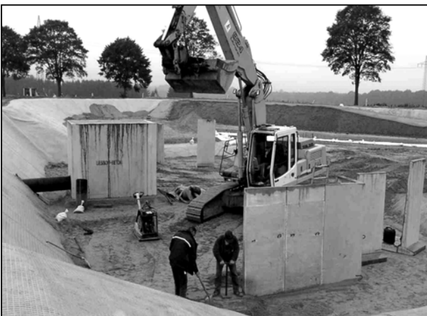
Abbildung 3 Schachtbauwerk mit darunter liegendem Dichtungssystem und Aufstellen der Winkelstützelemente für die Ölsperre
