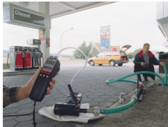
Überwachung der Tankstellendichtung mit dem PID.
