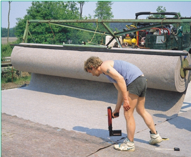
Maschinelle Verlegung der Vliesstoffe
