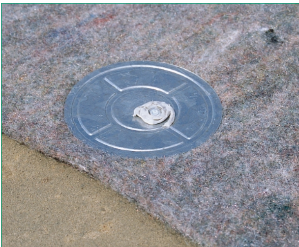
Stahlnägeln und Unterlegplatten fixieren den Secutex®-Vliesstoff
