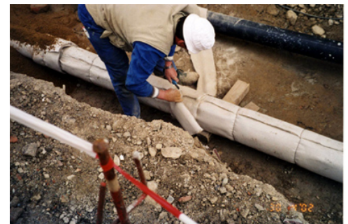
Befestigung von Bentofix® auf der Abwasserleitung
